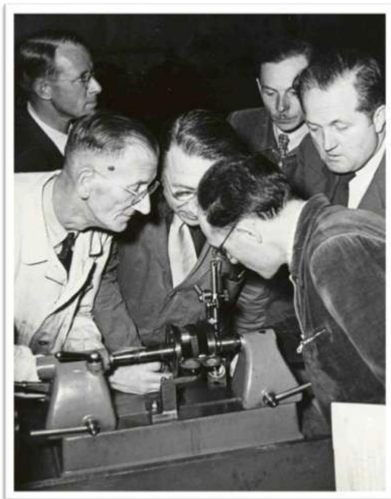
Bild 060: Die zwischen den spitzen laufende Kurbelwelle wird mit einer Batterie von Messuhren auf schlagfreien Lauf überprüft. Der vordere Hauptlagerzapfen zeigte einen Schlag von 0,025 mm, der hintere
