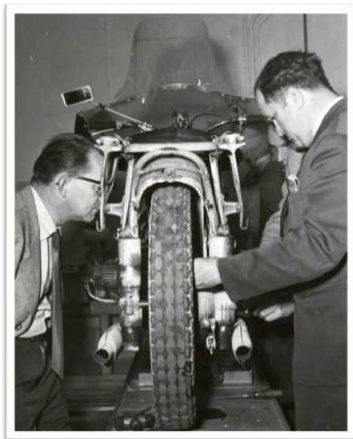
Bild 058: Weder Vorder- noch Hinterrad zeigten in den Lagern das geringste Seitenspiel, auf der ganzen Fahrt wurden nur zwei Hinterradspeichen gewechselt, die übrigen von Zeit zu Zeit nachgezogen. (F 32/L)
