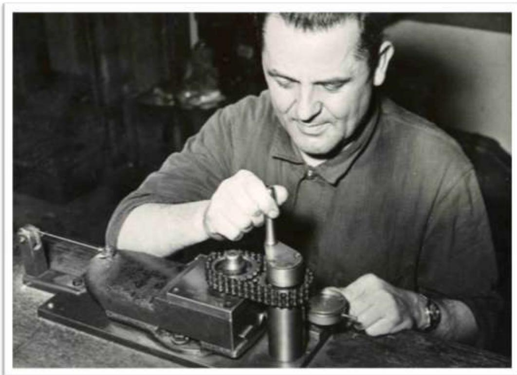
Die Längung der Getriebeketten wird auf dieser sehr einfachen, aber sehr geschickten Vorrichtung genau mit einer Meßuhr bestimmt. Sie lag, obwohl die Maschine sehr viel mit hoher Belastung in den Gängen
